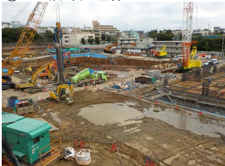
②ごみ焼却処理棟2
