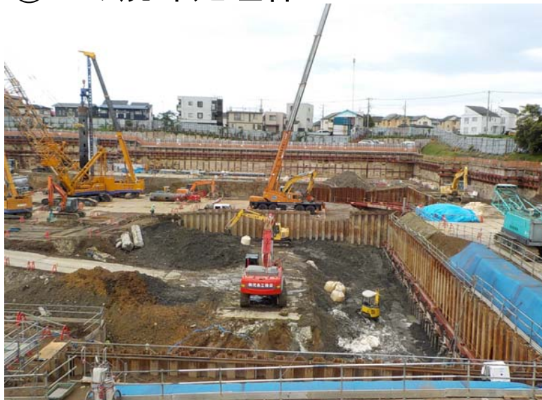
①ごみ焼却処理棟1
