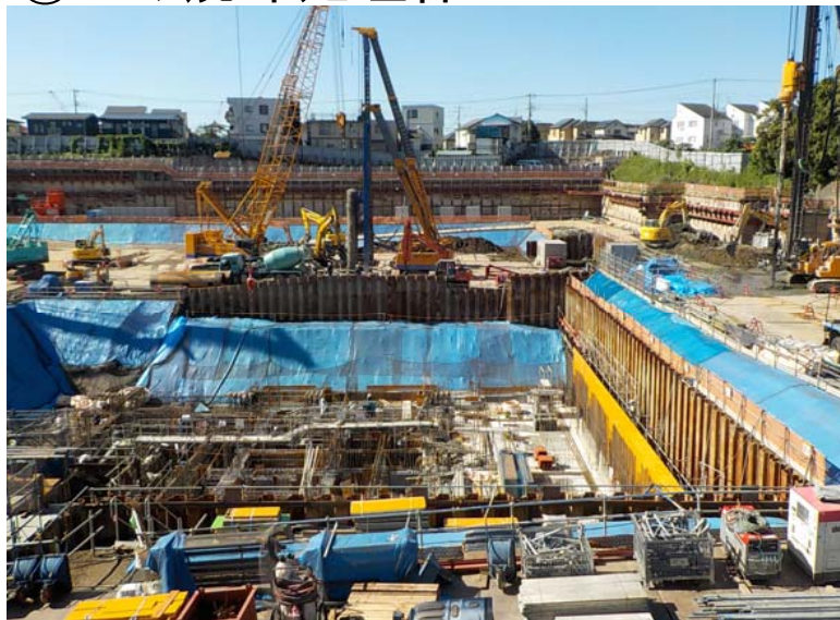
①ごみ焼却処理棟1
