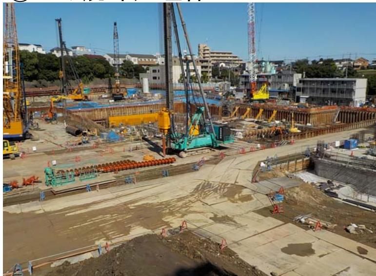
②ごみ焼却処理棟2
