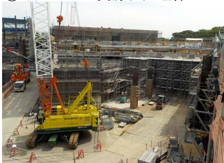
③ミックスペーパー資源化処理棟
