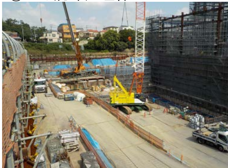
②ごみ焼却処理棟2
