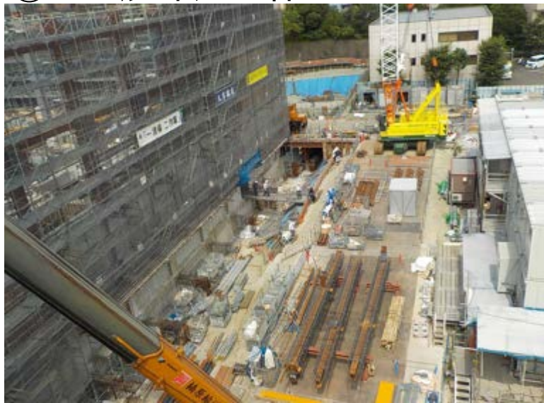
①ごみ焼却処理棟1
