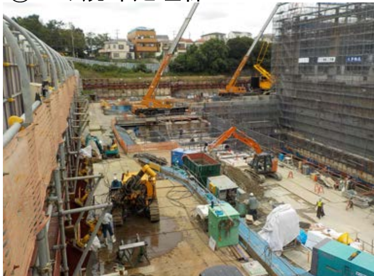
②ごみ焼却処理棟2
