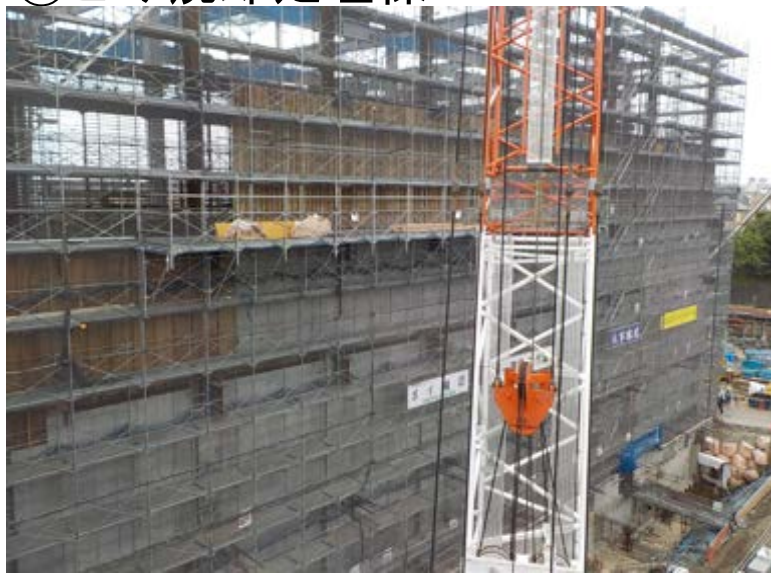
①ごみ焼却処理棟1
