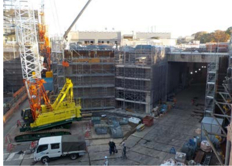
③ミックスペーパー資源化処理棟
