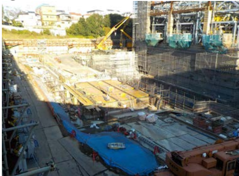
②ごみ焼却処理棟2
