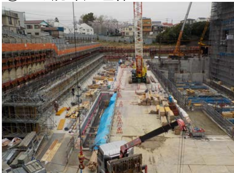
②ごみ焼却処理棟2
