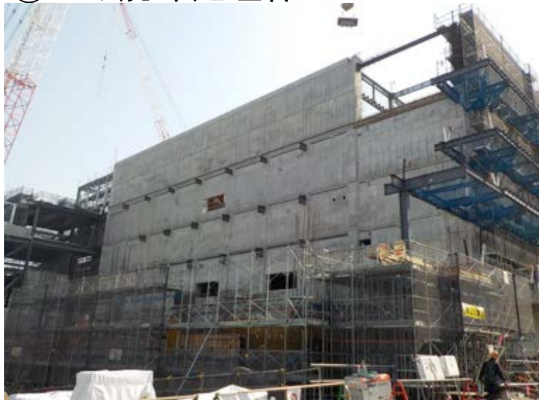
①ごみ焼却処理棟1
