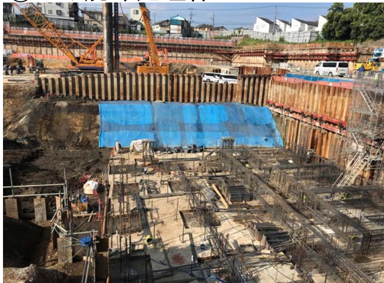
①ごみ焼却処理棟1
