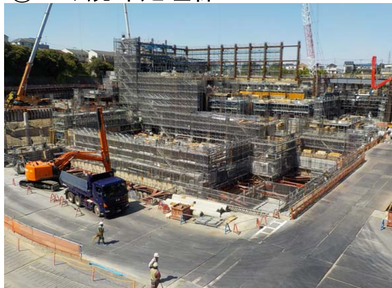
②ごみ焼却処理棟2
