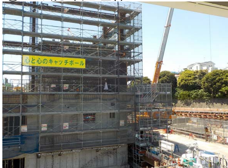
①ごみ焼却処理棟1
