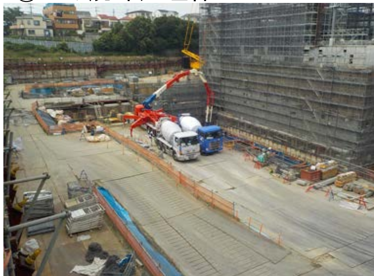
②ごみ焼却処理棟2
