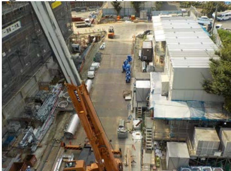
①ごみ焼却処理棟1
