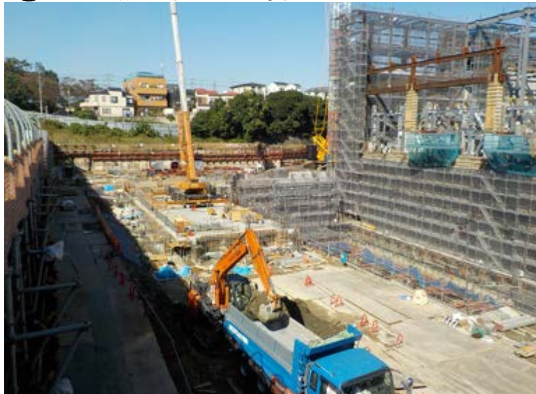
②ごみ焼却処理棟2
