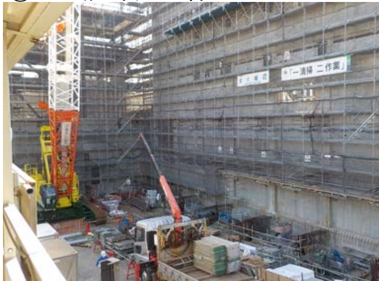
①ごみ焼却処理棟1
