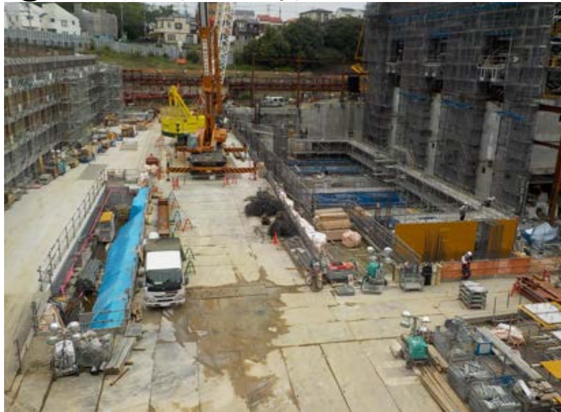
②ごみ焼却処理棟2
