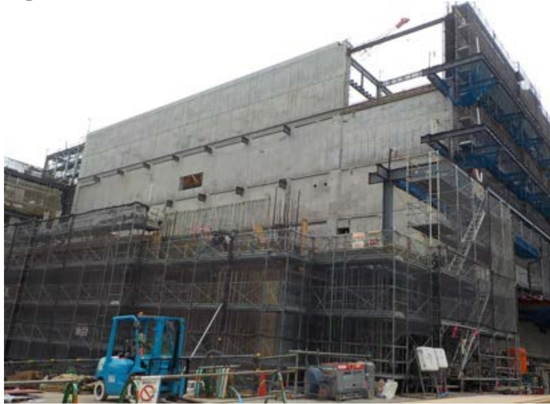
①ごみ焼却処理棟1
